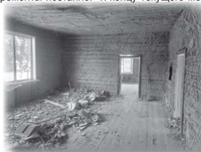
сяца планируется завершение 1 и 2 этапов выполнения работ, в рамках которых в Метляевском детском саду проведут ремонт чердачного перекрытия и крыши. Работы первых двух этапов также включают ремонт полов, частичную замену наружных венцов, рядовых брусьев и перепланировку здания сада. В детском саду села Кумарейка в настоящий момент занимаются демонтажем фасада, разбором полов, и снятием штукатурки внутри помещений.
